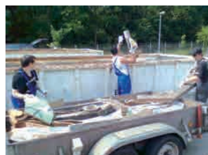
Abbrissarbeiten und Neuaufbau
