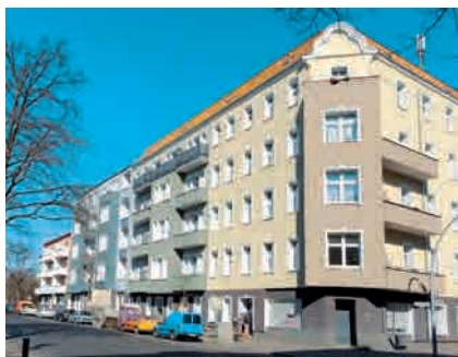
Die sanierten Gebäude setzen bewusst unterschiedliche farbige Akzente im Wohnquartier
