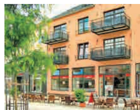
Bau und Modernisierung von Komfortwohnungen und Gewerbeeinheiten mit Freisitzen und Rampen
